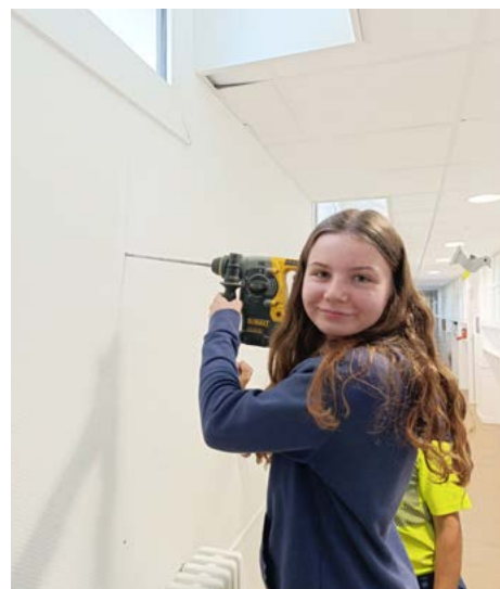
Eugénie en plein travaux !
