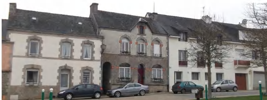
Inguiniel, place centrale Ensemble de maisons de bourg cadrant la rive nord de la place.
